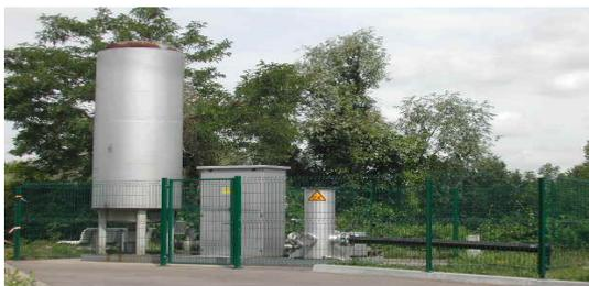
Les biogaz produits par les casiers exploités jusqu'en août 2006 sont collectés par un réseau de 20 puits et incinérés.
