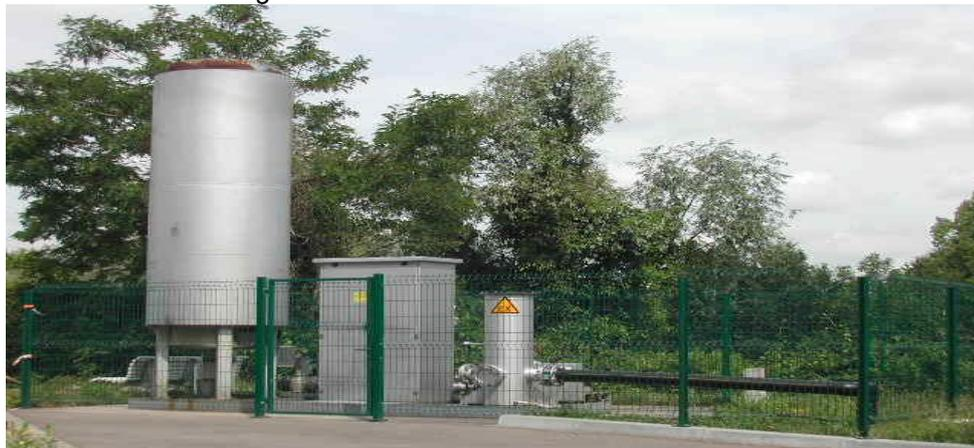
Les biogaz produits par les casiers exploités jusqu'en août 2006 et 2 puits du casier 3 (depuis le 06.05.2014) sont collectés par un réseau de 20 puits mis en dépression et dirigés vers une centrale de combustion installée à l'entrée du site. Cette centrale transforme le méthane du biogaz en gaz carbonique, dont l'effet de serre est 25 fois moins important, et casse les mercaptans responsables des odeurs.
