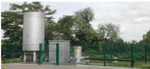
Les biogaz produits par les casiers exploités jusqu'en août 2006 sont collectés par un réseau de 24 puits et incinérés.
